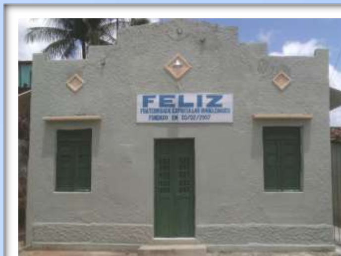
Fachada da instituição
